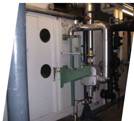
reinen, inspecteren van technische ruimtes
