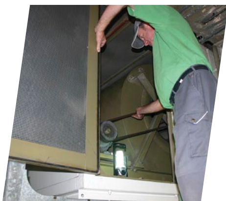
controleren, vervangen van V-snaren, V-snaaraandrijvingen en lagers
